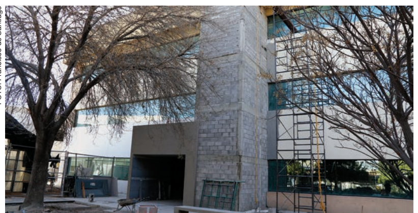
El edificio Q de ICB es remodelado en su totalidad.
