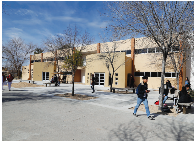
Vista exterior del edificio.
