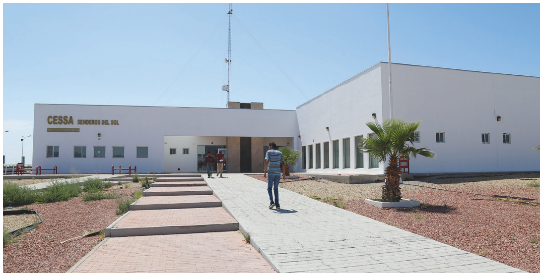
Centro de Salud con Servicios Ampliados, CESSA Senderos del Sol, ubicado en Av. Fundadores de América #4238
